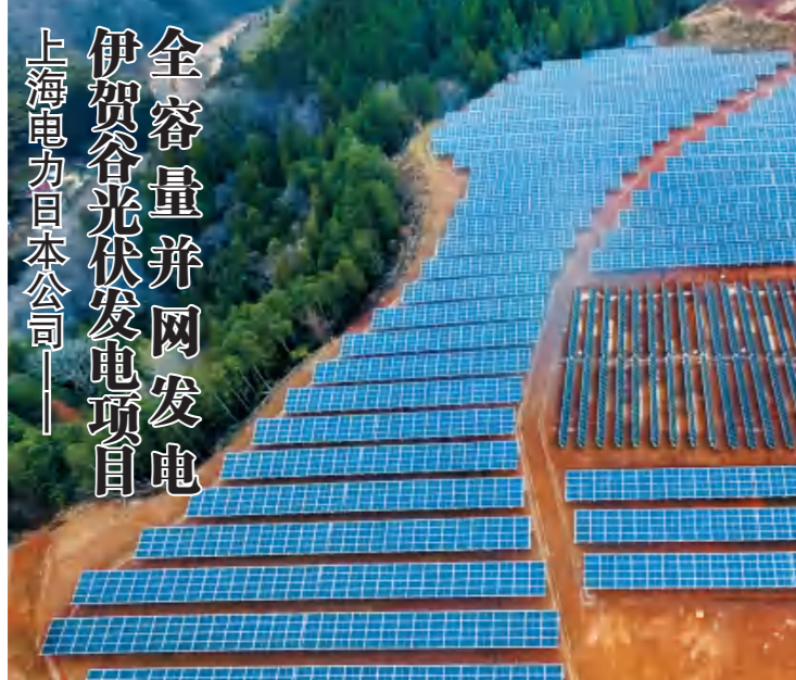
伊贺谷光伏并网发电项目
