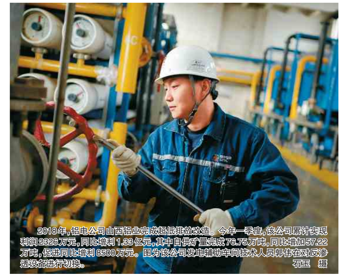
2018年,银电公司山西铝业完成超低排放改造。今年一季度,该公司原料实现利润2222万元,同比增长1.33亿元,其中自修炉工程完成76.78万吨,同比增加57.22万吨,提质增效盈利8000万元。图为该公司发电部检修车间技术人员郭伟在对设备检修进行初检。
