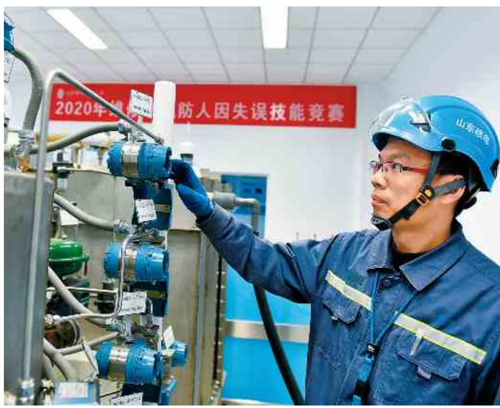
李子实在检查水箱液位控制系统压力变送器参数。姜涛 摄
