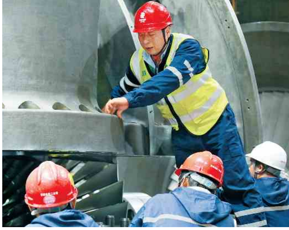
王勤正在检查汽轮机低压缸安装质量。赵子焕 摄
