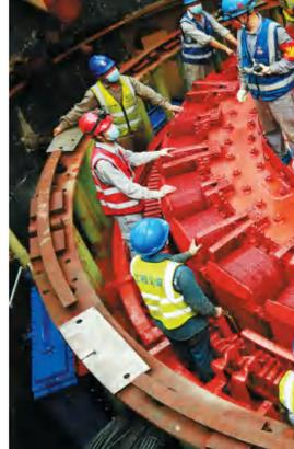
2号机组转子拥有14对磁极磁数,为此现场专门安排14名工作人员,手持木板以确保与定子之间的空气间隙。图为14员工齐心协力,核对定子之间的空气间隙。罗浩 摄
