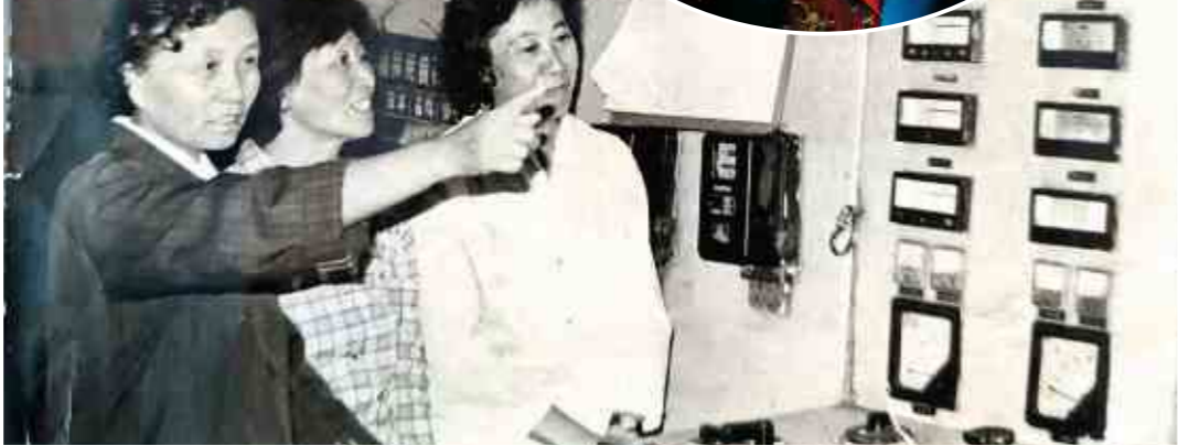
▲吴风云(右一)和同事们正在对机组运行参数数据进行分析核校
