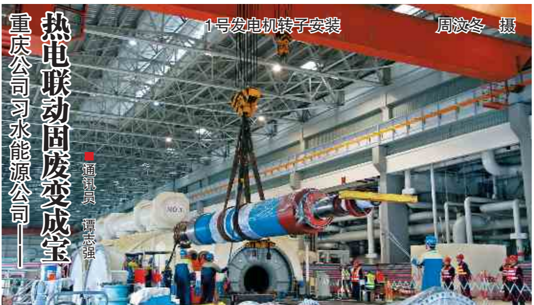
重慶公司习水能源公司1号发电机转子安装。周波 摄
