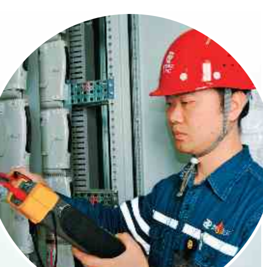
▲贵州金元黔西电厂生产现场热工人员5号660兆瓦机组DCS系统卡件测试。孔令捷 摄
