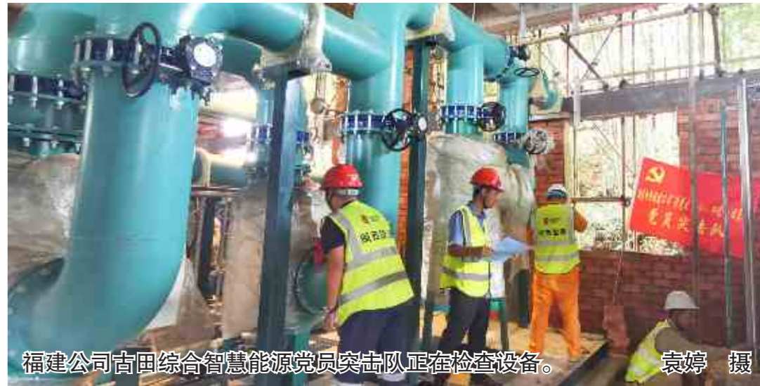
福建公司古田综合智慧能源党员突击队正在检查设备。袁婷 摄
