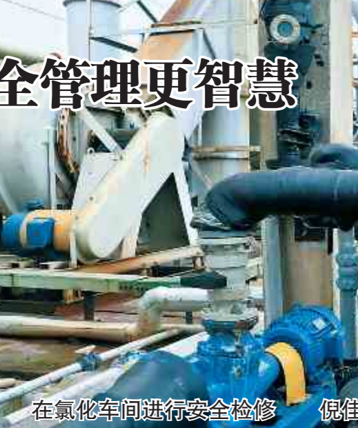
在氯化车间进行安全检修 倪佳采 摄
