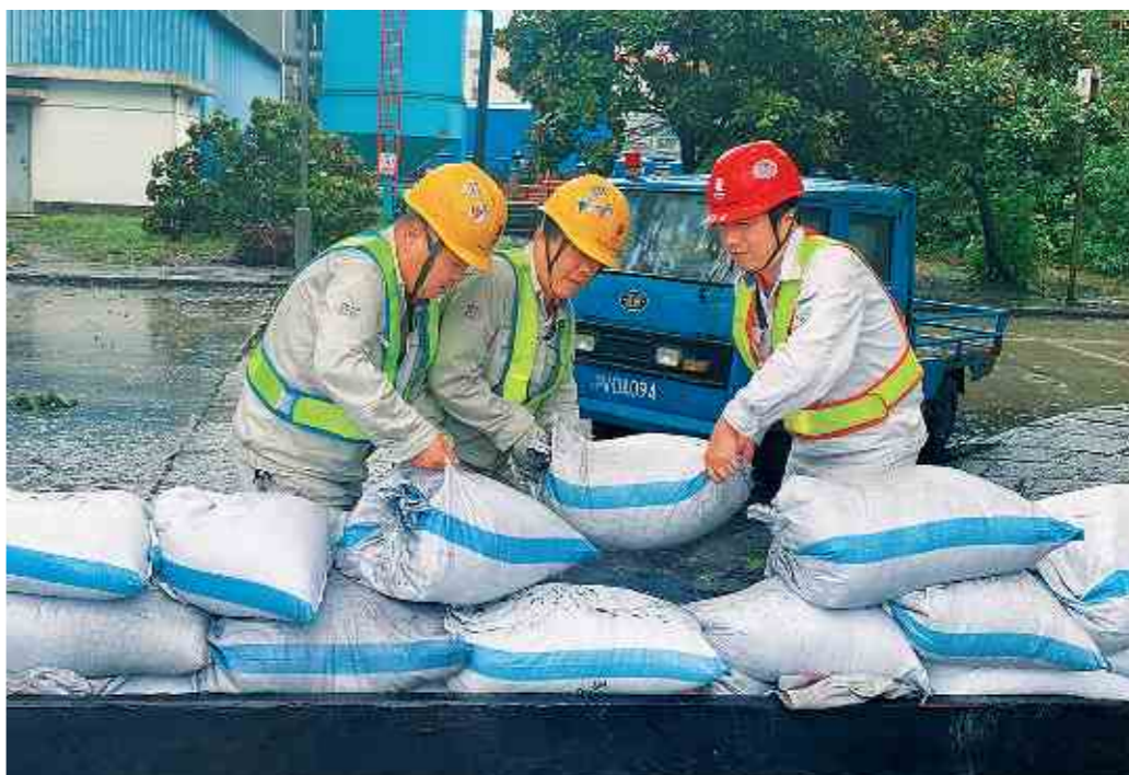
▲近日,台风“烟花”来袭,黄浦江水位不断接近防汛墙危险水位,上海电力吴泾电厂工作人员对沿江码头加装了防汛板,构筑堤坝防止江水倒灌。截至目前,该公司累计出动抢险人员53人次,应急车辆3辆,防汛沙包750包,防汛板32块,水泵6台,应急照明设施20件。图为该厂燃料部码头班用沙包堆砌起防汛板。赵梦 摄
