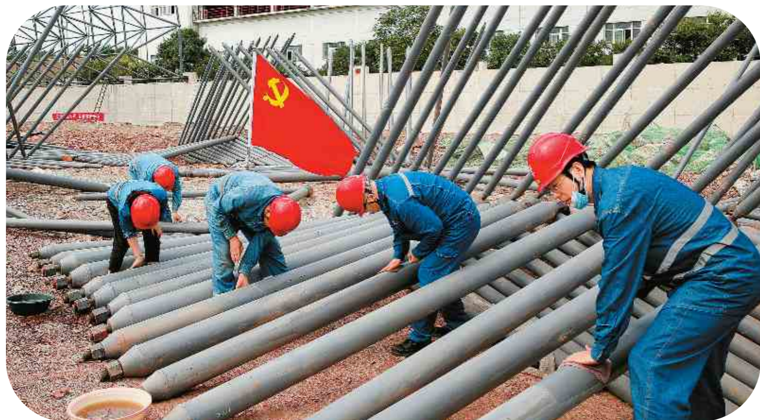
河南公司平顶山发电分公司安生党支部与设备维护党支部联合清理煤场扩建设施。
