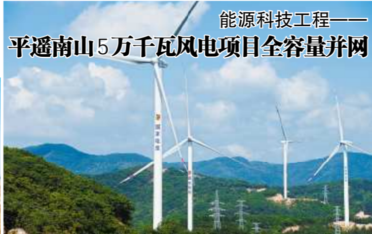
能源科技工程——平遥南山5万千瓦风电项目全容量并网 近日,随着第50台风机顺利并网,东北公司新能源公司年度三大“保电价”项目——大连驼山、朝阳建平、沈阳苏家屯风电项目全容量并网。该公司装机容量突破百万,达102.6万千瓦。 王玥 徐湘辉 摄影报道
