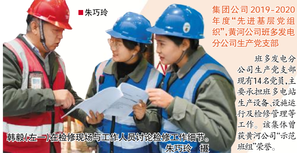
朱巧玲 韩毅(左一)在检修现场与工作人员讨论检修工作细节。
