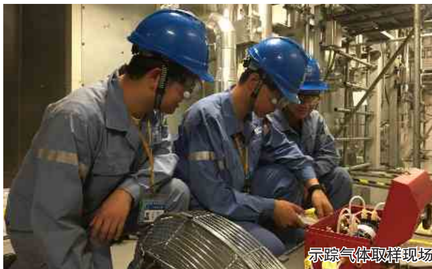
埋地双层管道泄漏点定位技术缺陷管线切割作业现场
