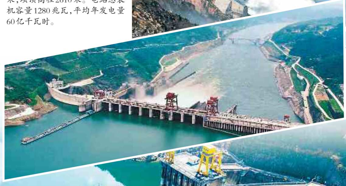
▲五强溪水电厂是湖南省最大的水电厂,中国十大水电站之一,最大坝高87.5米,坝顶高程117.5米,坝顶长717.73米。总装机容量1200兆瓦,五强溪水电厂枢纽工程建成后,形成了170平方公里的“高峡平湖”。
