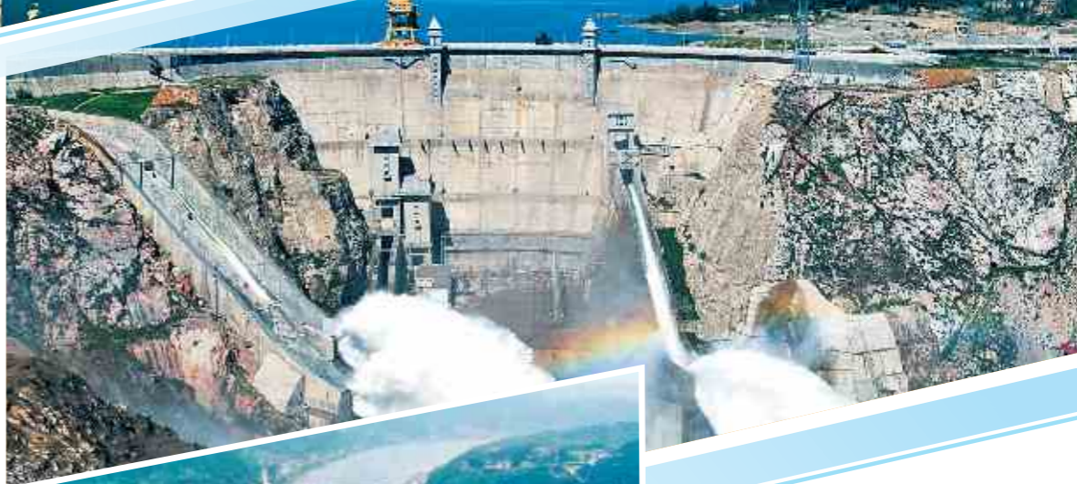
▲五强溪水电厂是湖南省最大的水电厂,中国十大水电站之一,最大坝高87.5米,坝顶高程117.5米,坝顶长717.73米。总装机容量1200兆瓦,五强溪水电厂枢纽工程建成后,形成了170平方公里的“高峡平湖”。
